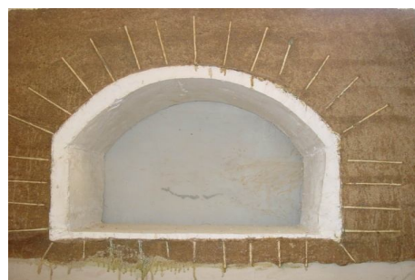
(c) 支护洞 M2 断面破坏形态
